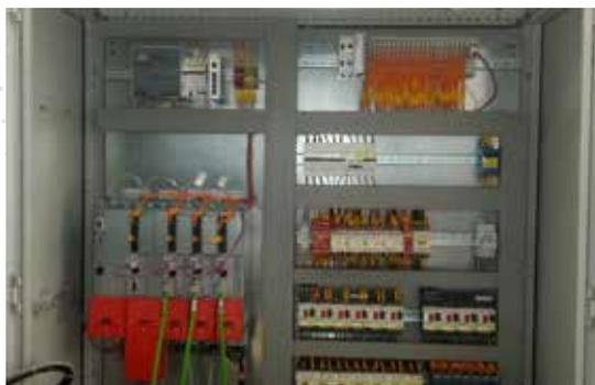
Quadro di controllo con PLC e inverter SERVO
