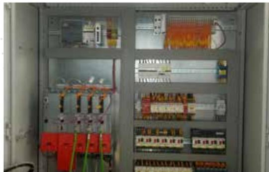
Armoire de commande avec automate programmable (PLC) et variateurs SERVO
