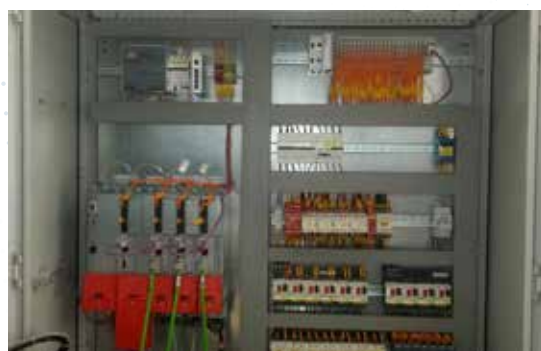
Шафа керування зі контролером PLC та сервоприводними перетворювачами частоти
