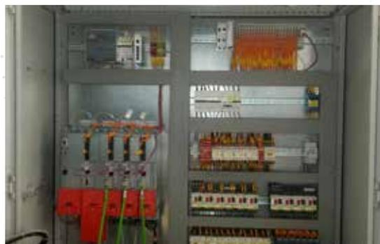
Painel de controle com controlador PLC e inversores SERVO
