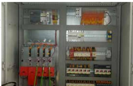
Armario de control con PLC y variadores SERVO.
