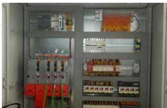
Szafa sterownicza ze sterownikiem PLC oraz falownikami SERVO
