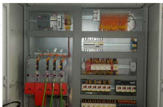
Szafa sterownicza ze sterownikiem PLC oraz falownikami SERVO
